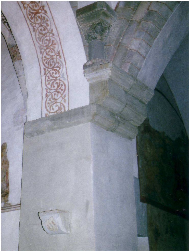
Abb. 16 N0-Vierungspfeiler der Stiepeler Dorfkirche mit v.d.Recke-Wappen am Kragstein
